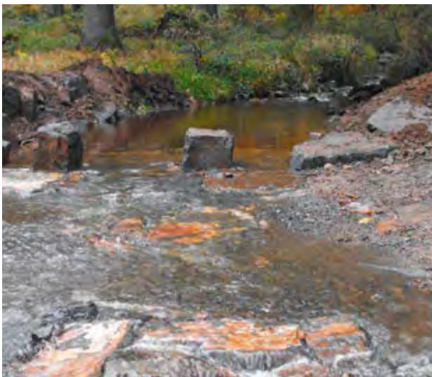
Die neue Furt mit Sohlgleite
