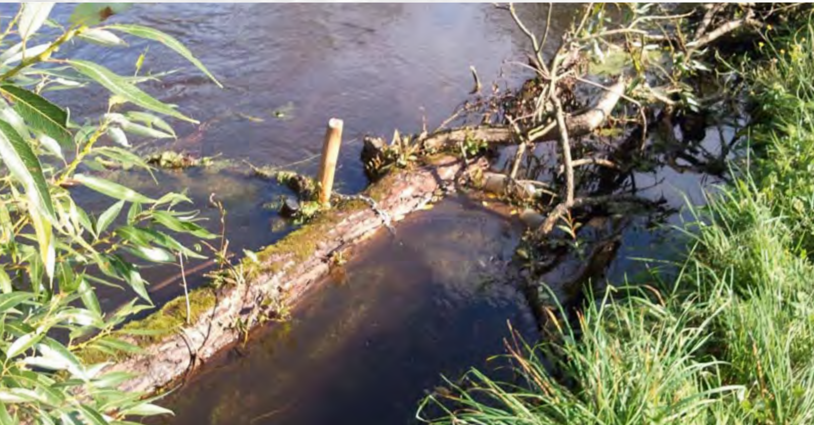
Die Sicherung der Erlen mit Ketten verhindert ein Abtreiben bei hohen Abflüssen
