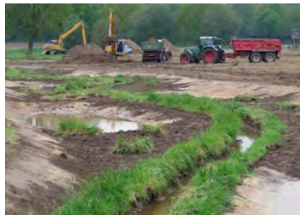
Der neue, geschwungene Bachlauf mit Sekundäraue wird angelegt
