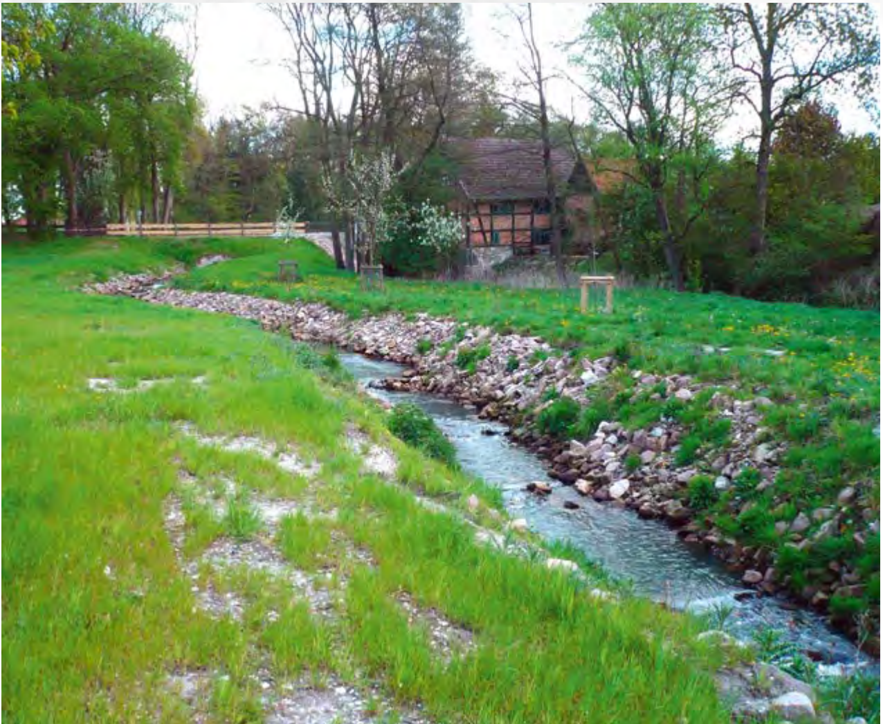
Nachher: Das Umgehungsgerinne hinter der Brücke. Der Höhengsprung des Wehres von 3,36 m wird durch einen Umfluter ausgeglichen.
