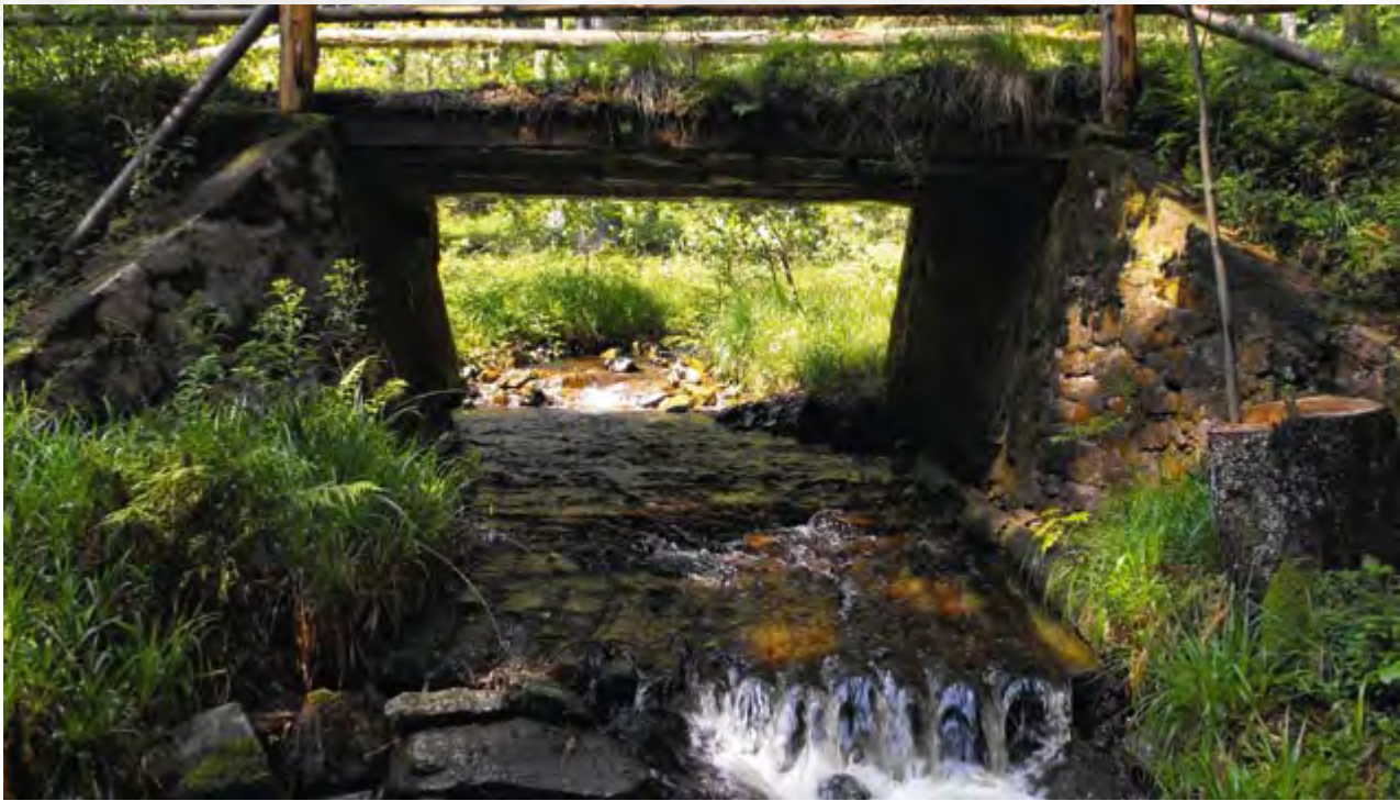
Ausgangssituation: die Brücke mit Sohlabsturz vor der Maßnahme
