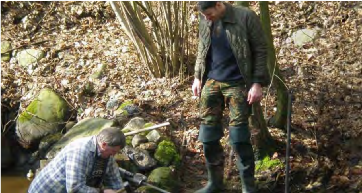
Die Arbeiten an der Fischtreppe
