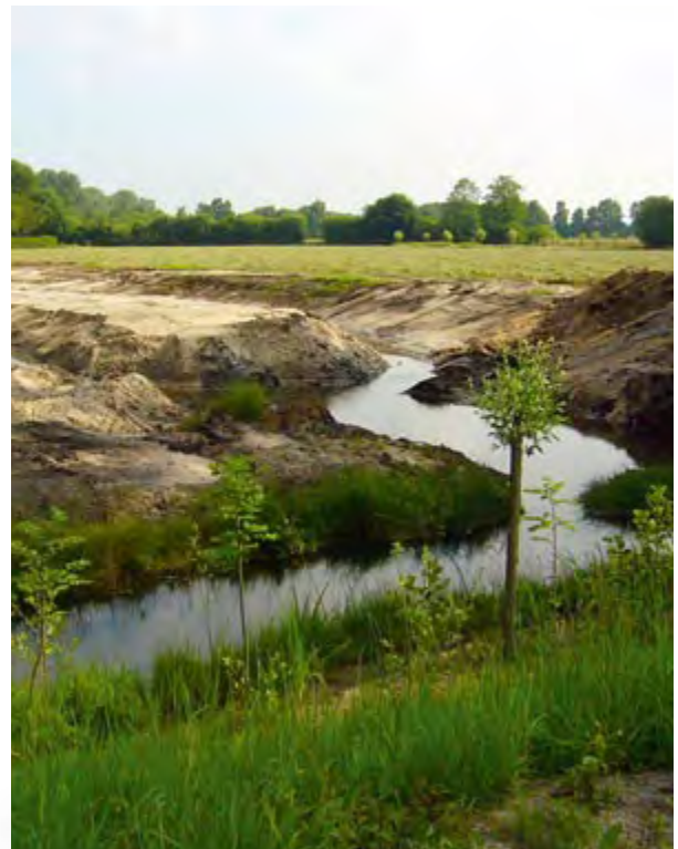
Arbeiten am Altarm (2005)
