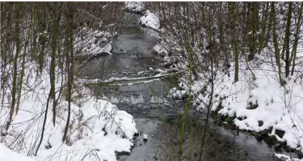
Düte im Bereich Kohlenwiese nach der Maßnahme
