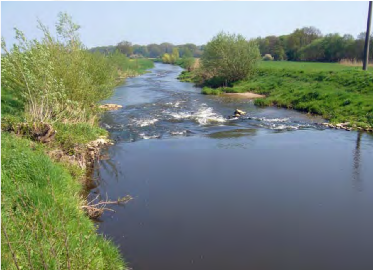
Die Vechte mit Sohlgleite, beidseitigen Uferrandstreifen und extensiv bewirtschafteter Aue
