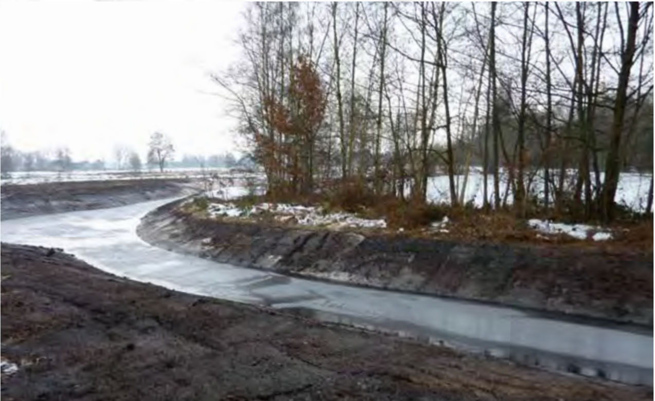
Nachher: Der neue Gewässerlauf der Hausbäke mit Sandfang (im Hintergrund der Teich)
