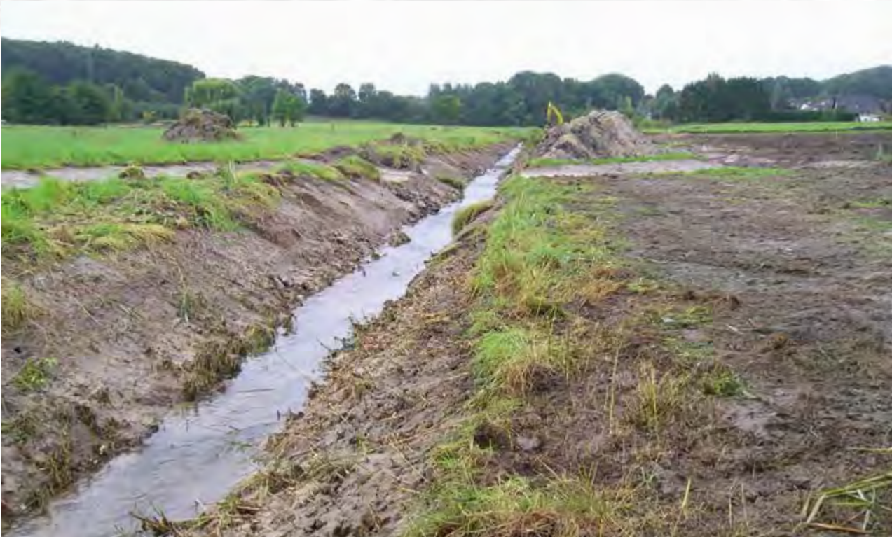
Alter Verlauf des Königsbaches (der neue Verlauf ist bereits querend erkennbar)
