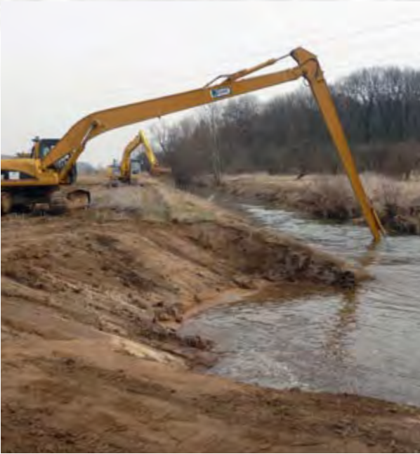
Renaturierungsarbeiten an der Schunter (2010)
