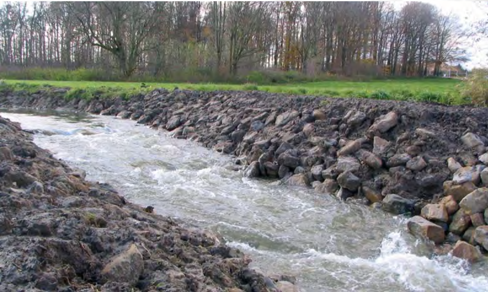
Durchgängigkeit durch den Bau einer Sohlgleite
