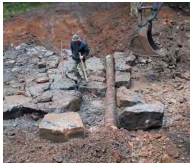
Während der Baumaßnahme
