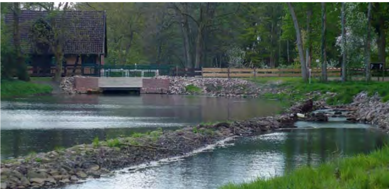
Nachher: Der entschlammte Teich mit angrenzender Fischtreppe, die in einem neuen Durchlass (rechts neben der sanierten Brücke) die Straße unterquert.
