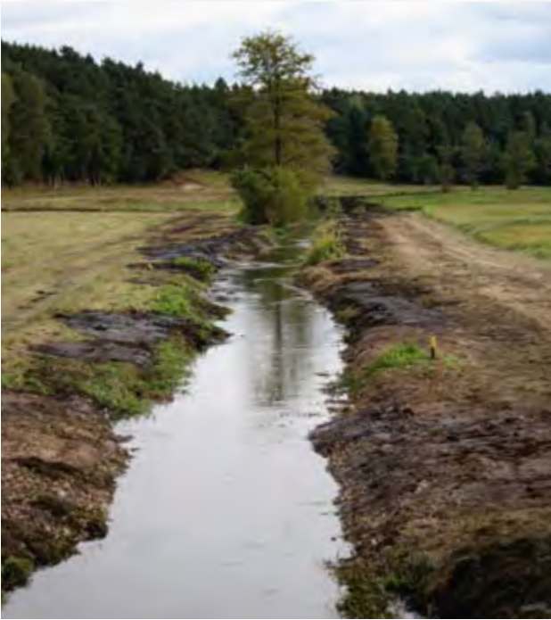
Aubach nach Vollendung der Maßnahme
