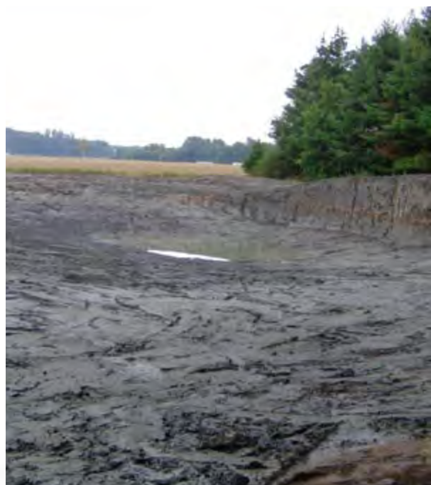
Fertigstellung des Landschaftsteiches (2005)
