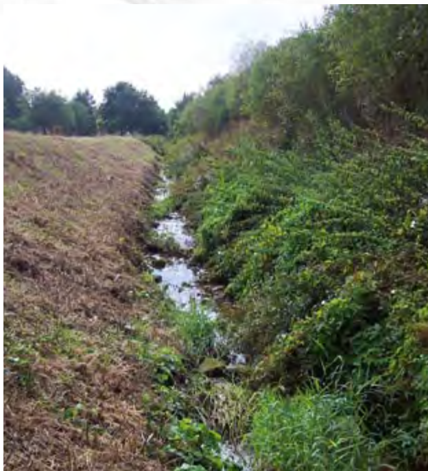
Alter Gewässerverlauf unterhalb der Verrohrung
