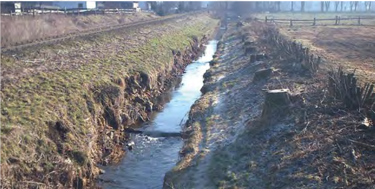
Düte vor der Verlegung
