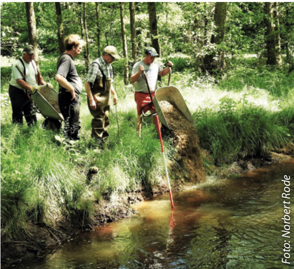
Einsatz von Schubkarren zur Bekiesung vom Ufer
