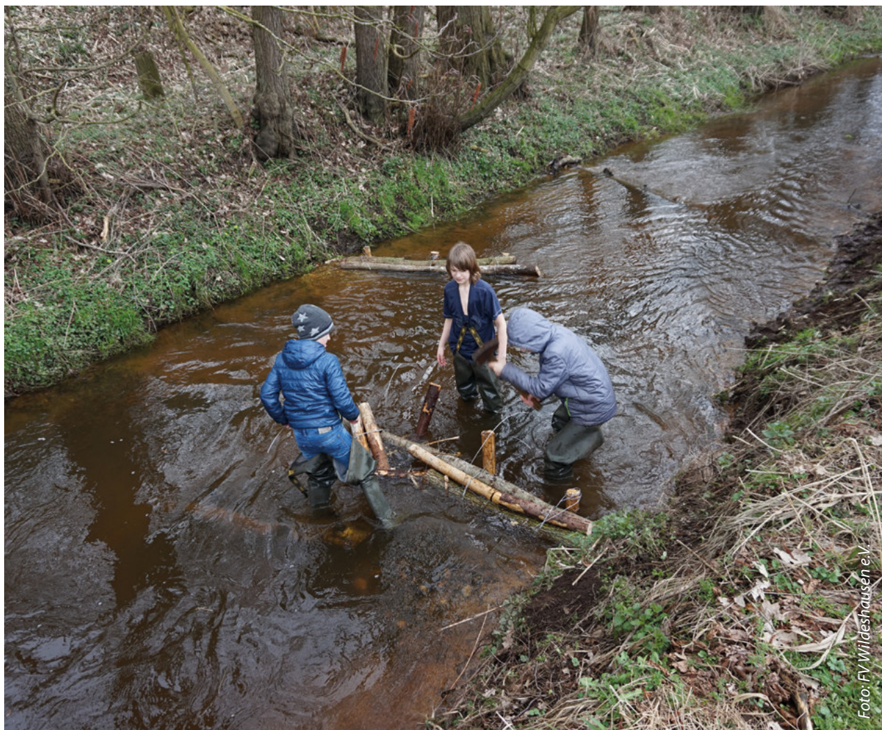
Die Strömunglenker werden gesichert
