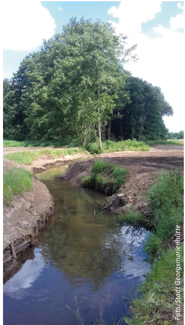
Düteabschnitt kurz nach Durchführung der Maßnahmen
