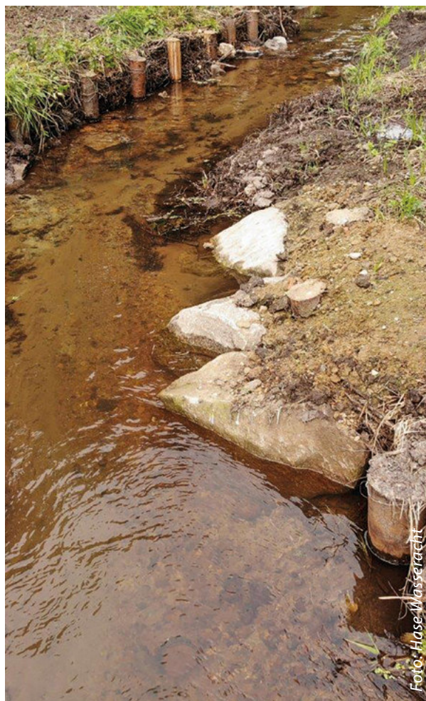
Eingebrachte Störsteine und Faschinen nach der Baumaßnahme
