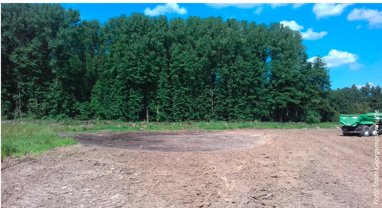
Abgrabung der Blänke im Bereich der westlichen Fläche
