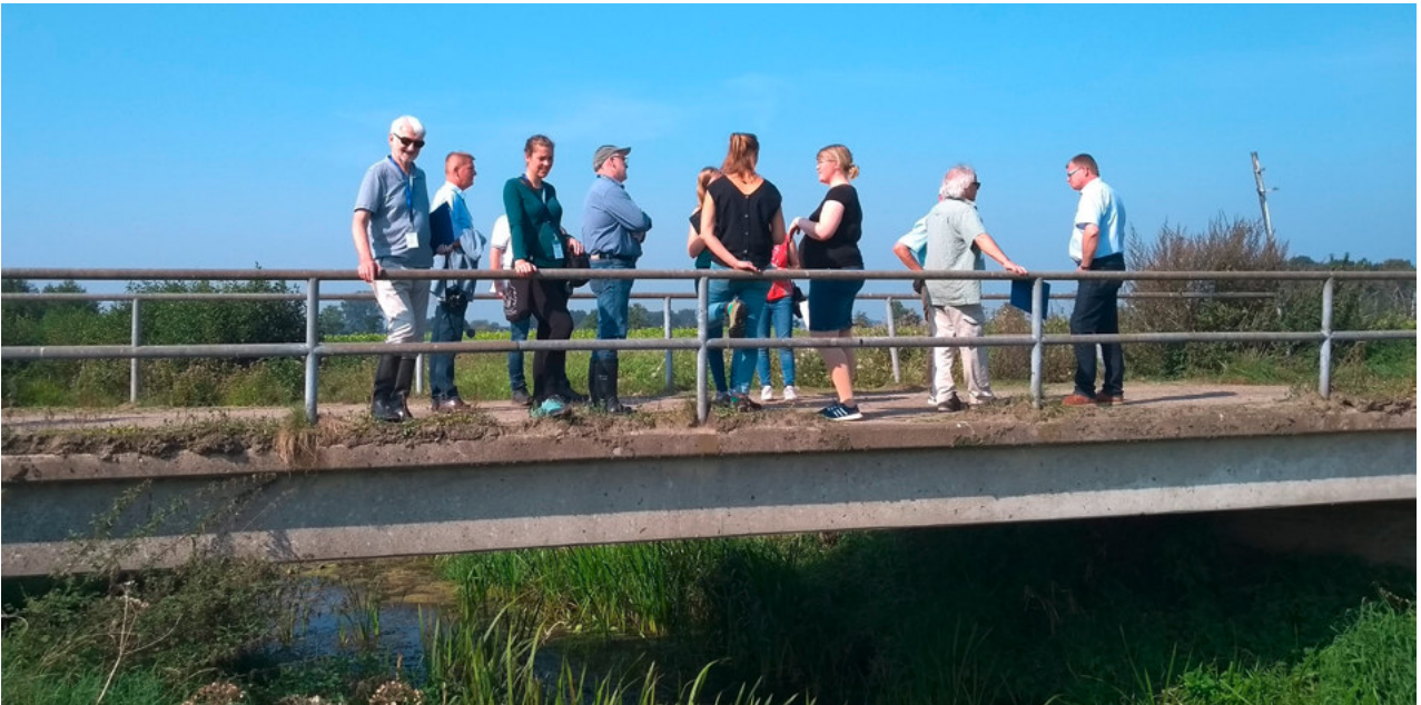
Die Jury begutachtet die Maßnahmenstrecke
