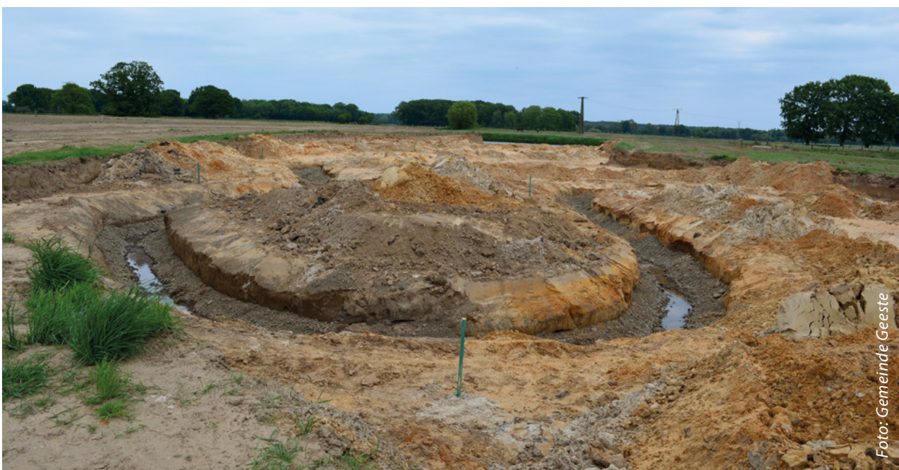
Neuer Verlauf der Moorbeeke kurz nach den Bauarbeiten
