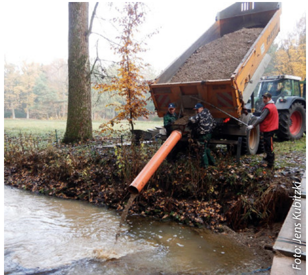
Kieseinbringung mit Rohr
