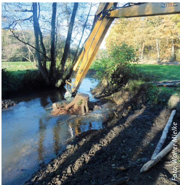
Der Bagger platziert die Wurzelstubben
