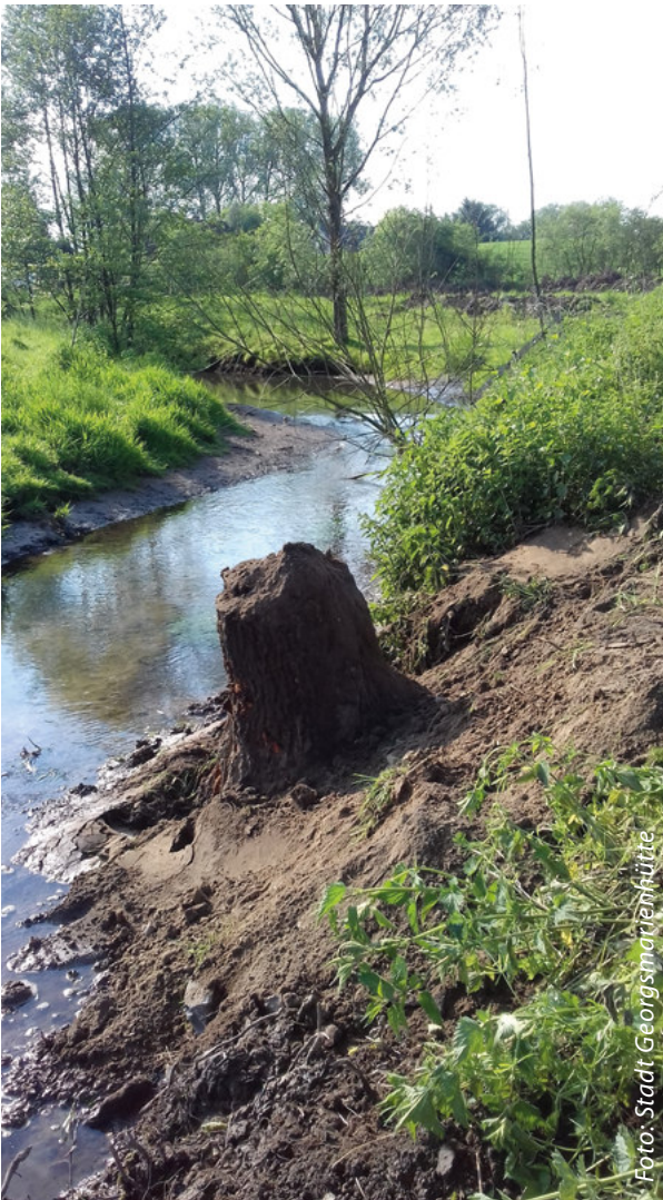
Eingebauter Wurzelstubben als Totholzelement
