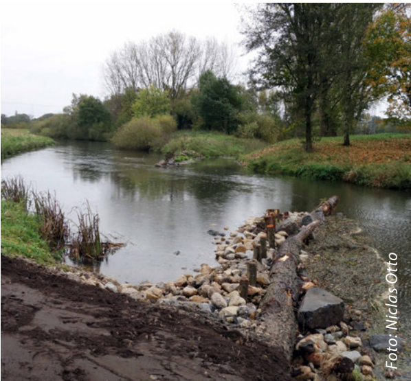
Fertig gestellter Strömunglenker
