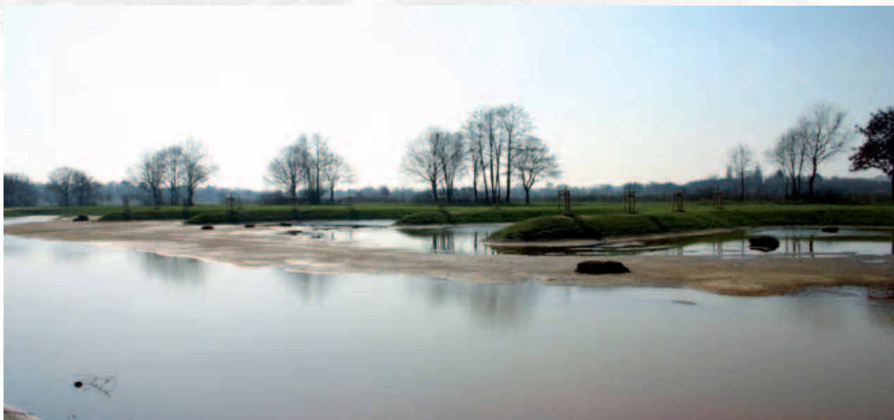
Der Altarm nach Fertigstellung der Erdarbeiten
