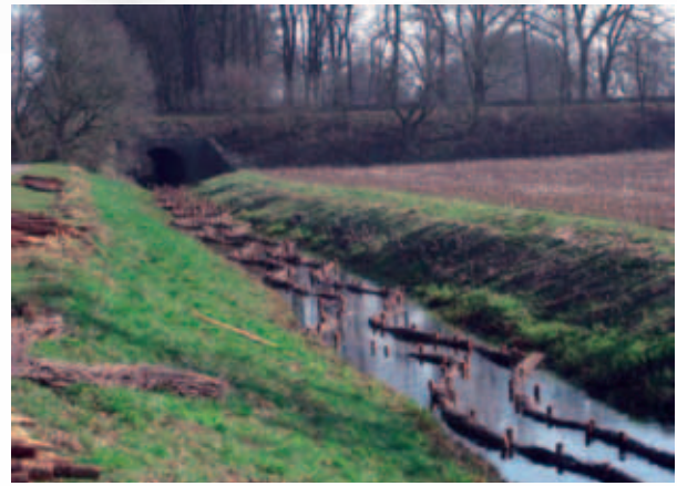
Auf einer Länge von 400 m wurden Faschinen eingebracht (Initiator für eine eigendynamische Gewässerentwicklung).
