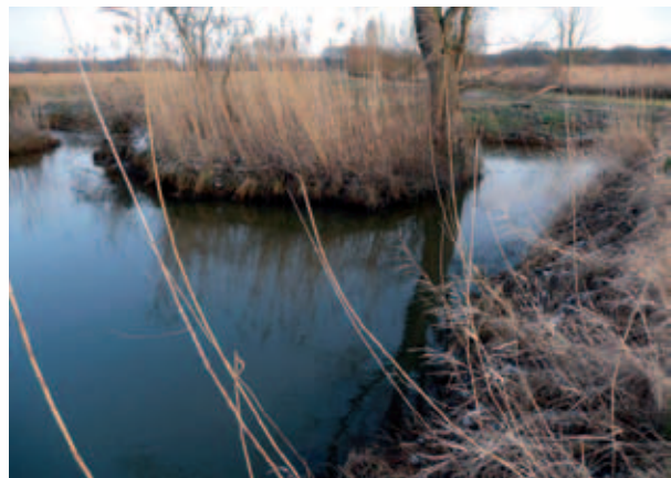
2005: Durchstich des Altarmes zum Hauptentwässerungsgraben
