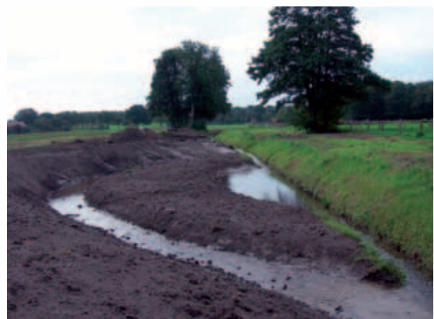
Endzustand kurz nach Fertigstellung
