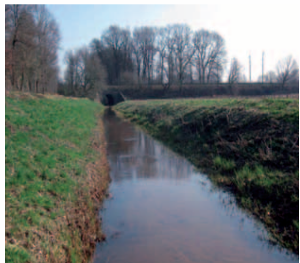
Ausgangssituation: Typisches Trapezprofil, gerader Verlauf mit breitem Sohlprofil.
