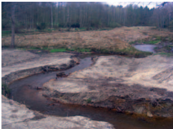
Der neue Verlauf in Höhe des ehemaligen Bahndammes/Wehres, 5 Monate nach Fertigstellung
