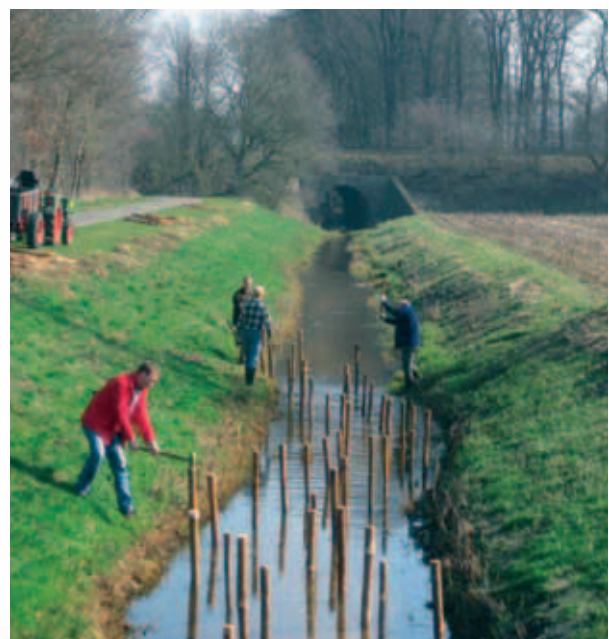
Profilierung des neuen Gewässerverlaufs (März 2011)
