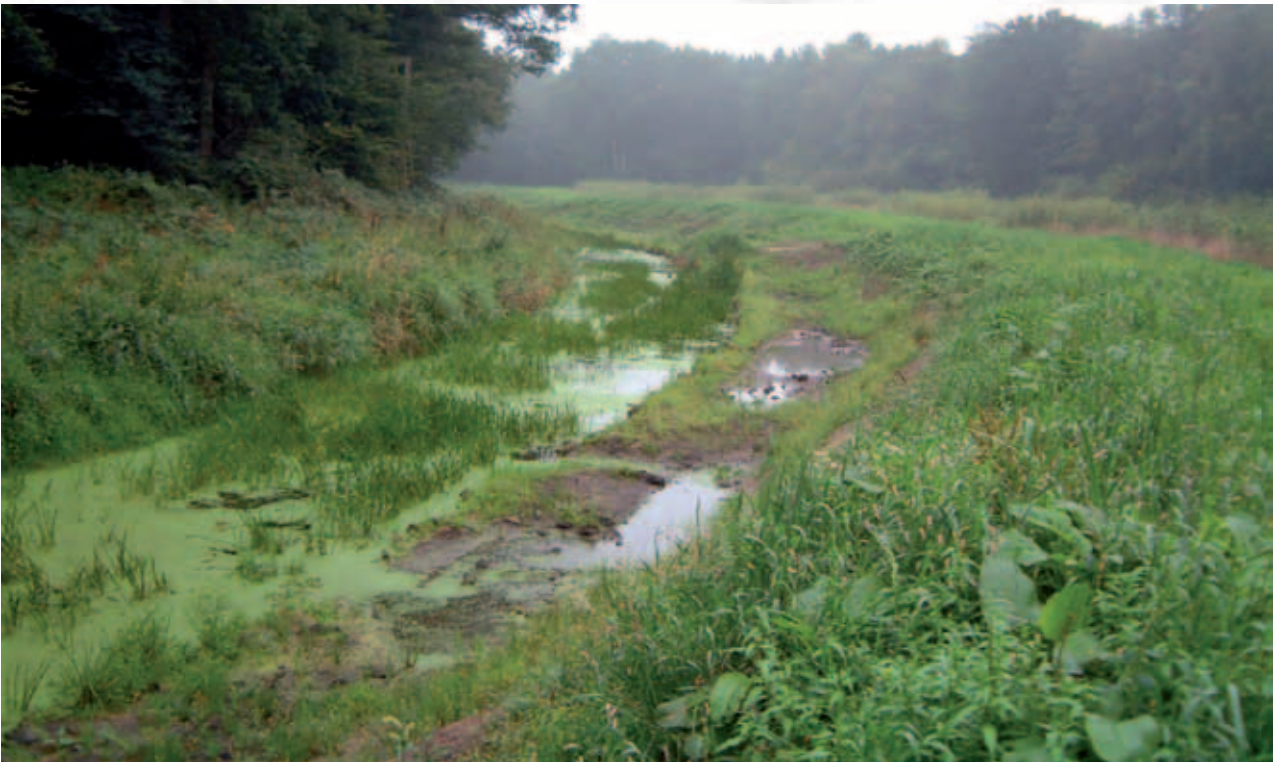
Mittelwasserberme an der Eileringsbecke
