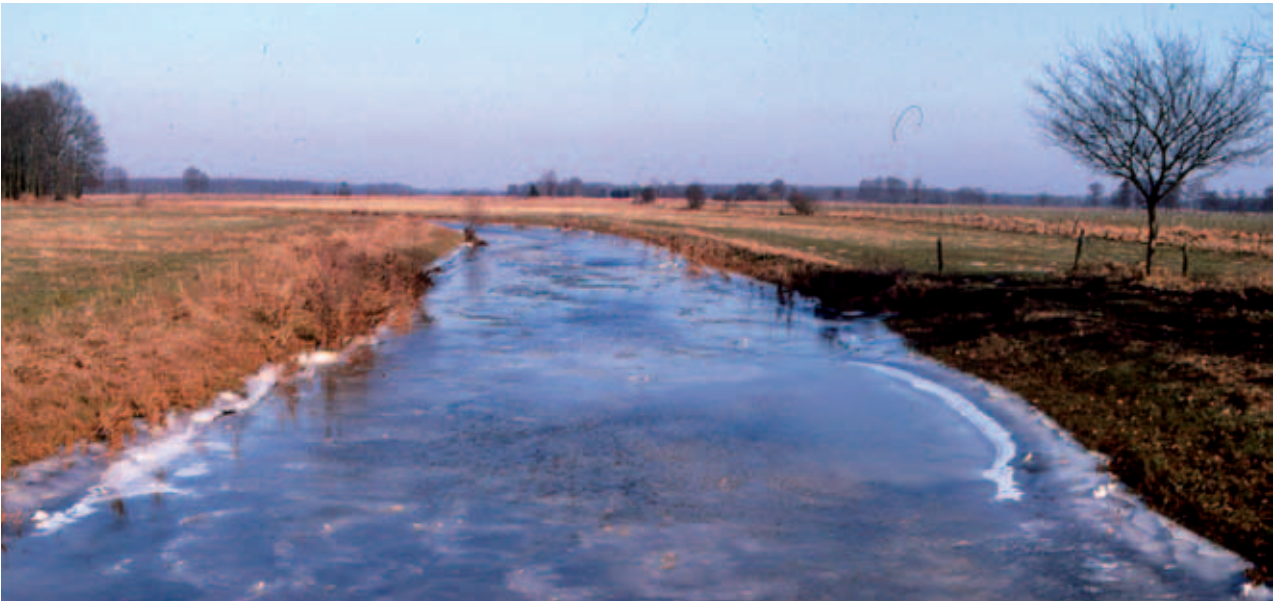
1994 Vorher: Intensive Gewässerunterhaltung an der Ise bei Gamsen
