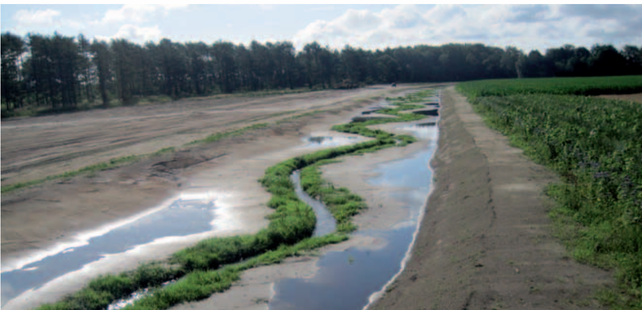
Nach dem Umbau: Ein geschwungener Bachlauf
