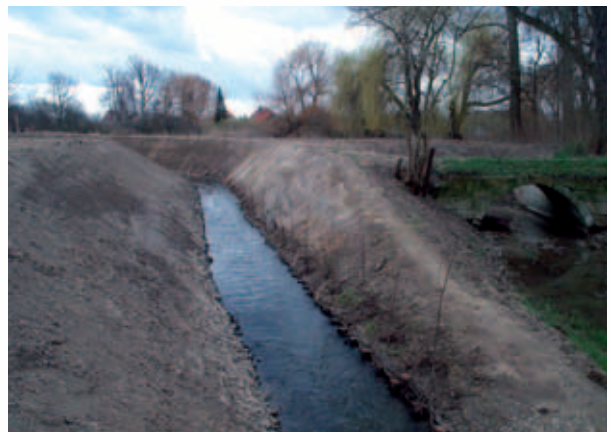
2006: Neuer Lauf nach Fertigstellung (Faschinen+ Erlenbepflanzung)
