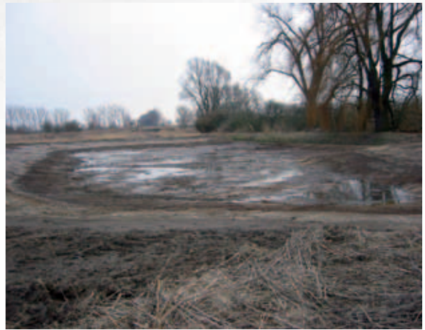
2006: Aushub der Senke zur Hochwasserrückhaltung
