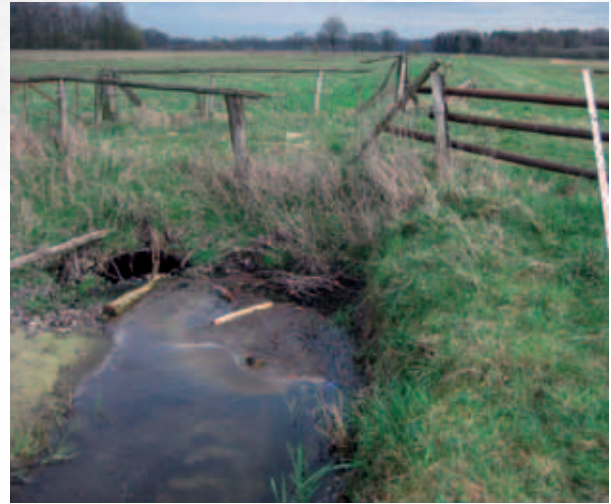
Ausgangszustand: Sohlabsturz kurz vorm Durchlass
