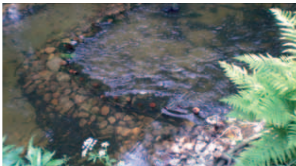
Einbau von Kartoffelsesteinen, mit Totholz fixiert
