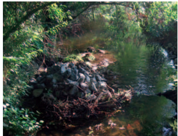
Detailansicht eines Strömunglenkers
