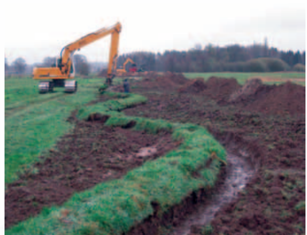
Ufersicherung durch Grassoden
