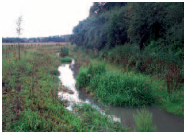
Abschnitt II nachher, flache Böschung und Verschwenkungen (2004)
