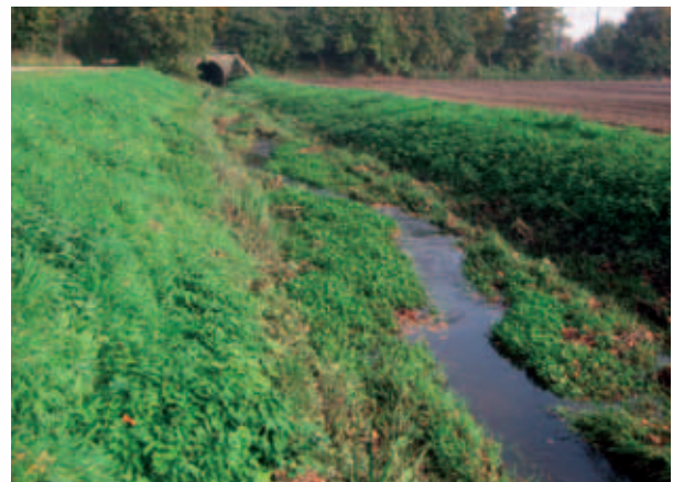
Ein Jahr nach Fertigstellung sind die Böschungen und Faschinen-Auffüllungen dicht bewachsen.
