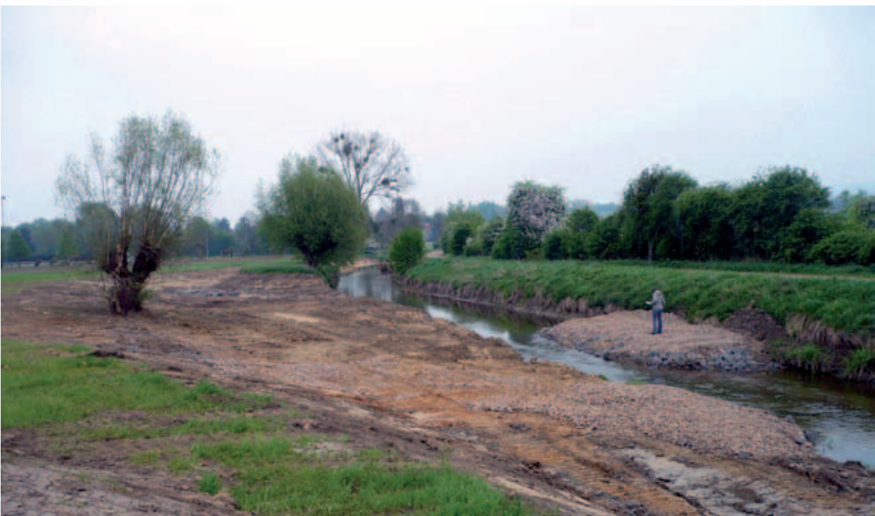
Nach Fertigstellung im Mai 2011 (Blick Richtung Osten)
