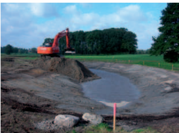
Baggerarbeiten am Amphibienteich
