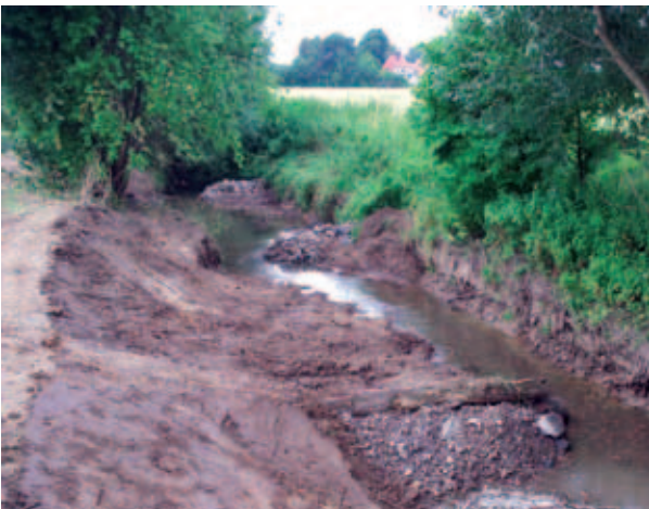
2. und 3. Schritt - Einbau von Strömunglenkern und Feuchtbermen
