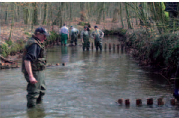
Einbau der Treibselfänger
