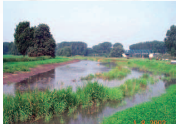
Abschnitt 3 nachher, Böschungsabgrabung und Aufweitung oberhalb der Mittelwasserlinie (2002)
