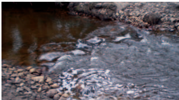
Einbau von Kartoffelsesteinen in der Este
