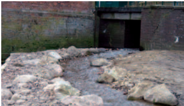
Blick auf Sohlgleite Richtung Oberlauf
