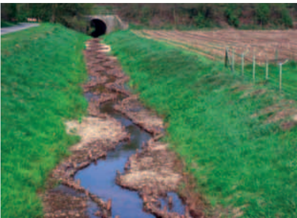
Die Maßnahme kurz nach der Fertigstellung. Die Wechselseitige Einengung des Gewässerbettes bewirkt ein Freispülen der Sohle.
