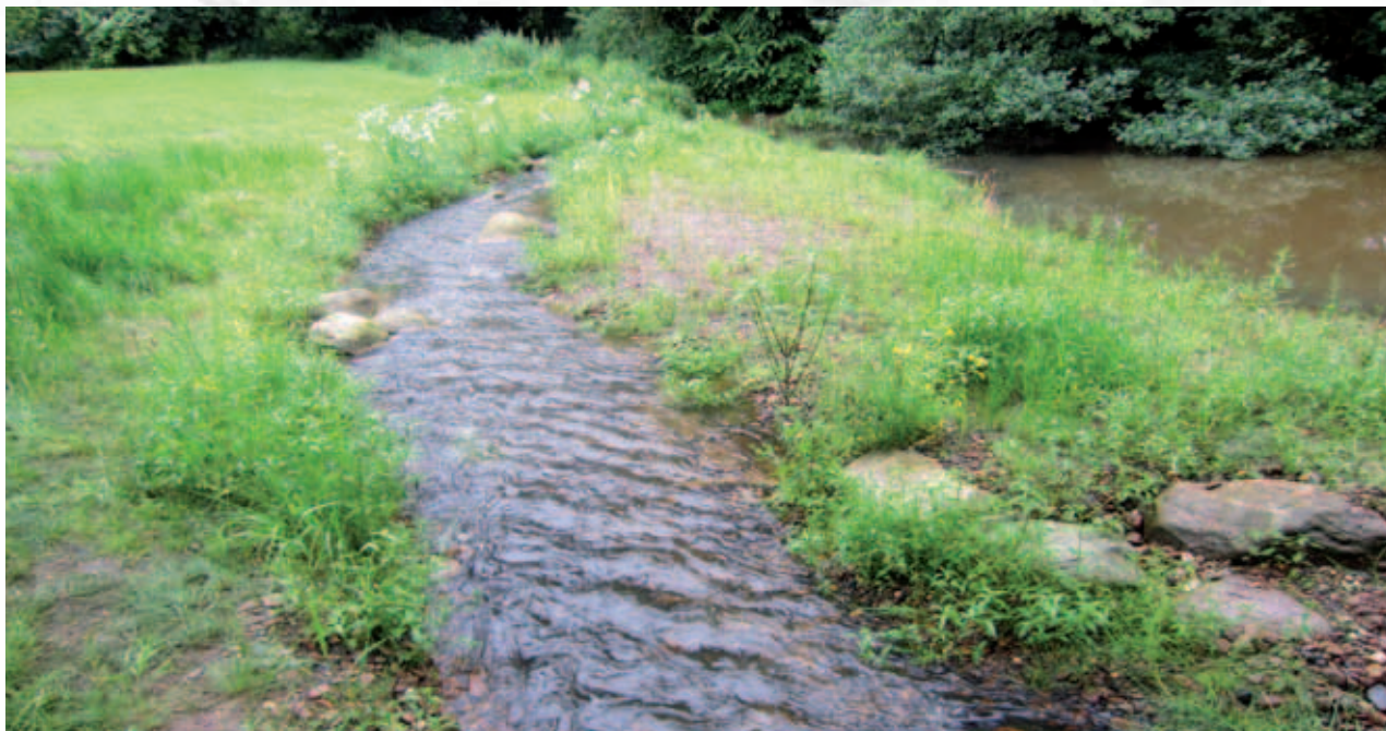
Nach dem Umbau I
