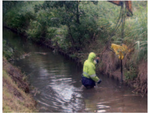
1. Schritt - Ausbau der Böschungfußsicherung
