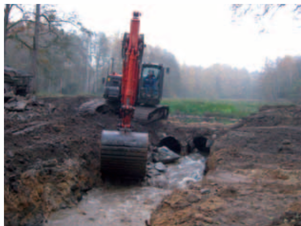
Abbruch der Verrohrung - Damm und Wehr sind bereits abgetragen
