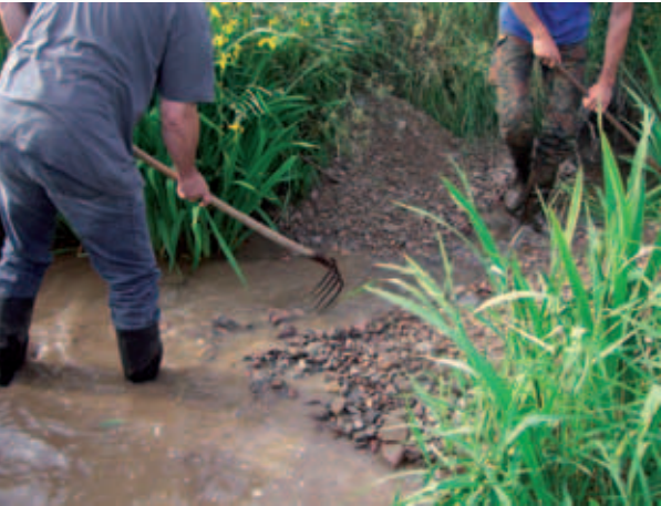
Einbau der Kiesbänke
