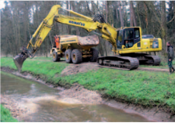
Einbau von Hartsubstrat in Form von Kiesbuhnen
