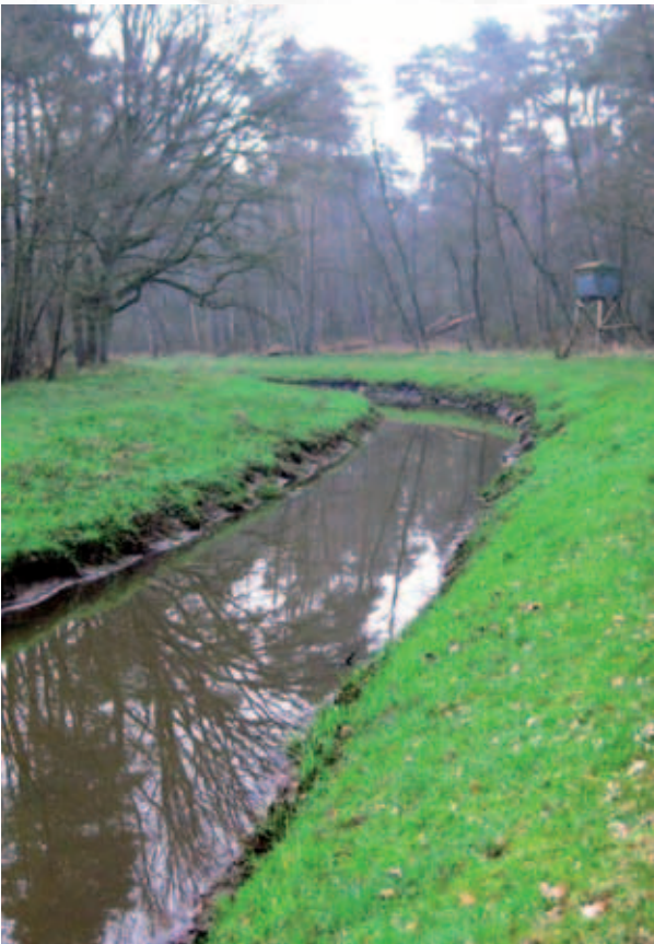
Die ausgebaute Eileringsbecke vor Beginn der Maßnahme
