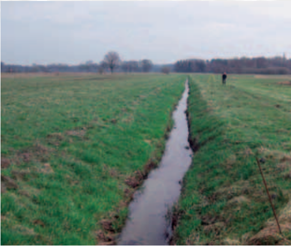
Vor der Maßnahme (gerades Trapezprofil)
