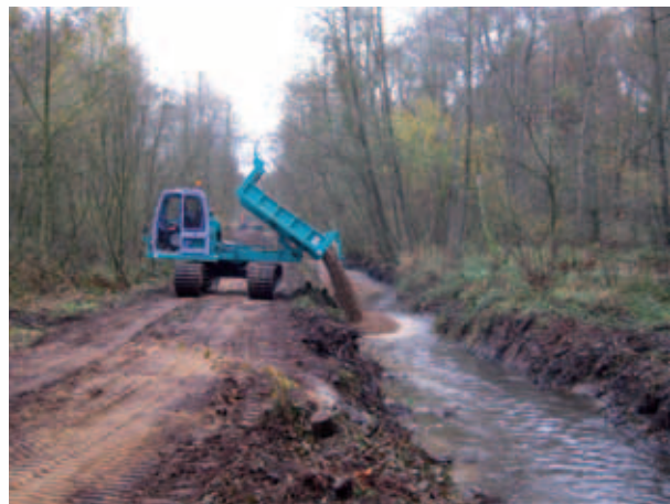
Effizient - Kieseinbau als „Starthilfe“ fürs Gewässer, das sich fortan eigendynamisch entwickeln kann
