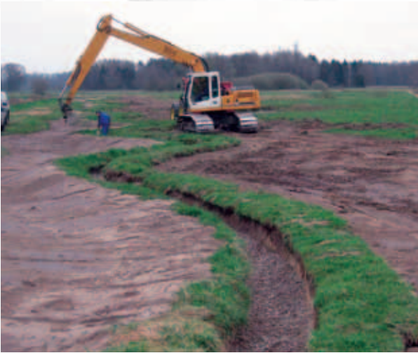
Einbau von Sohlsubstrat ins geformte Bachbett dient der Wiederherstellung des Lückensystems in der Sohle.
