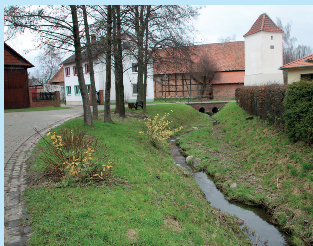
Im Ortskern wurden schon früher Teile der Betonhalbschalen entfernt und ein Retentionsraum mit Berme geschaffen. Die Aufwertung des Ortsbildes ist offensichtlich. (Foto: UAN)
